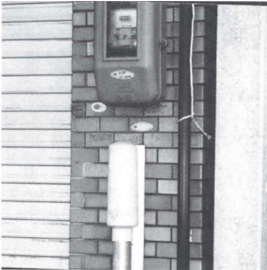
〔現場取付状況〕
