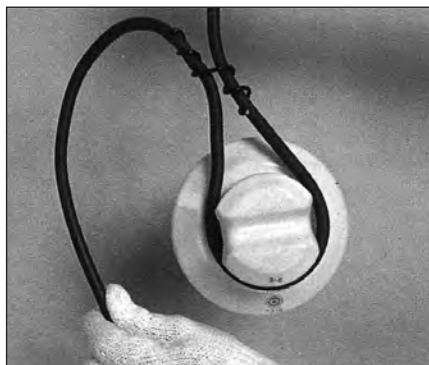
引下線上部取付方法（箇所）
