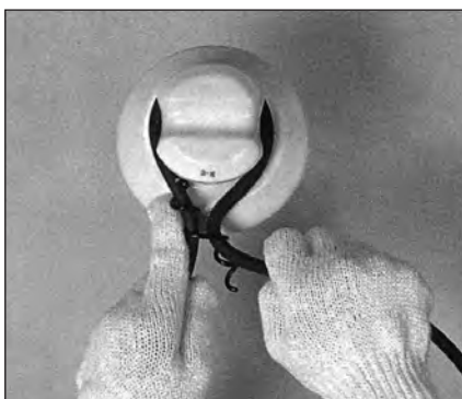
写真の様に分岐線をマキクリップに巻きこむ。
