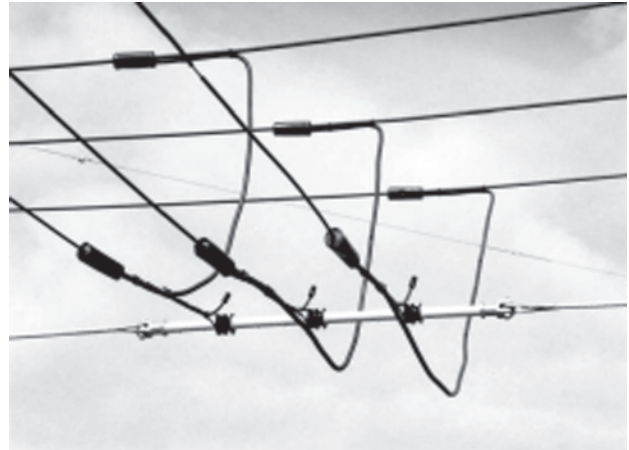
【高圧水平T分岐ポリマースペーサ：一般用】
