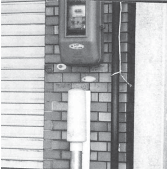
〔現場取付状況〕
