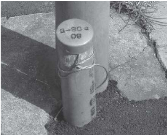
鉄製キャップ(フック付) (ケーブル引込用呼び線引留フック付)
