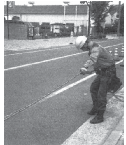
〔施工中の状況〕
