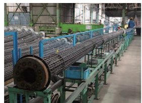
●ポール用編成台 直線切断機で切断された鉄筋を設計通りに編成します。
