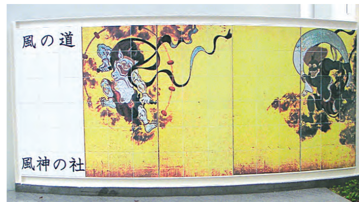
<300mmタイル(非透水)90枚を壁面に使用(1800mm x 4500mm)>
