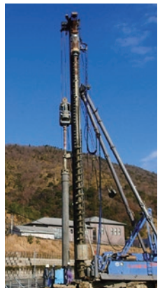
建設基礎工事に使用される「パイル」
