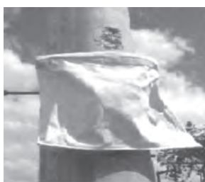
② 落下防止袋の設置
