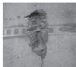
③ 鉄筋へ補修材の塗布
