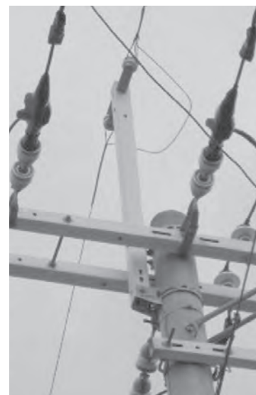
① 架空地線用腕金AB ② 取付金物 (小)
