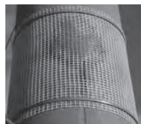
⑥ 剥落防止ネット取付け
