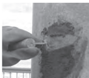
⑤ 補修面のコテ仕上げ
