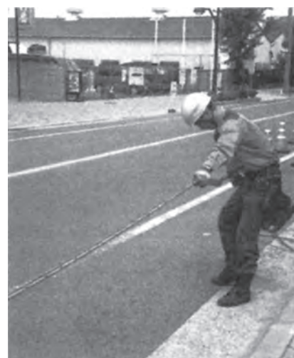
〔施工中の状況〕
