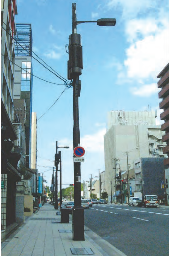
ソフト共用柱(高圧)
