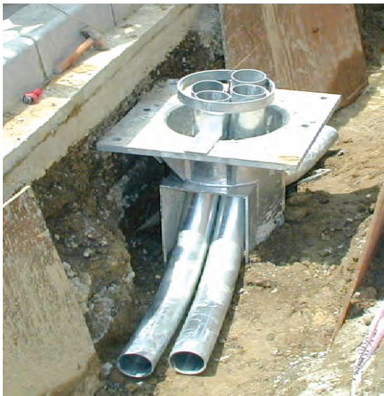
共用柱鋼管基礎施工
