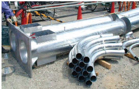
共用柱鋼管基礎部材
