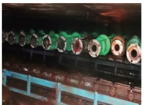
●蒸気養生室 遠心機で成形された型枠を養生室に入れて蒸気養生をし、製品の強度を促進させます。
