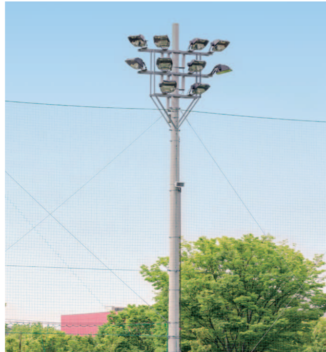
● 照明用ポール(兵庫県神戸市)
