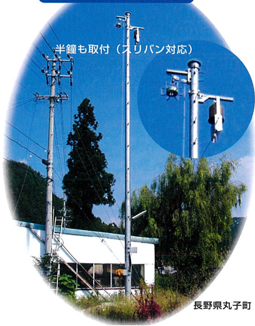
片側ウインチ式6本吊り
