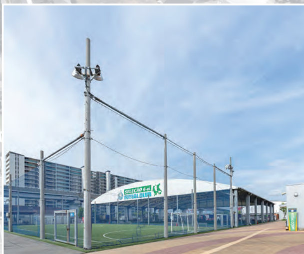
防球ネット柱(サッカー場)
