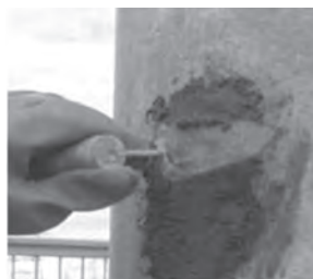
⑤ 補修面のコテ仕上げ
