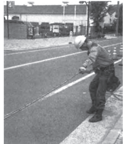
〔施工中の状況〕
