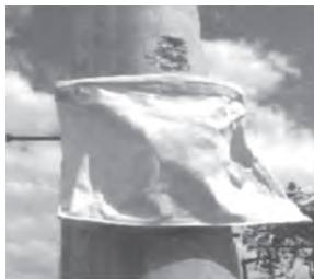
② 落下防止袋の設置
