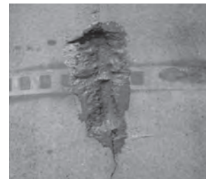
③ 鉄筋へ補修材の塗布
