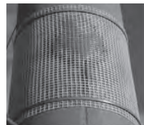
⑥ 剥落防止ネット取付け
