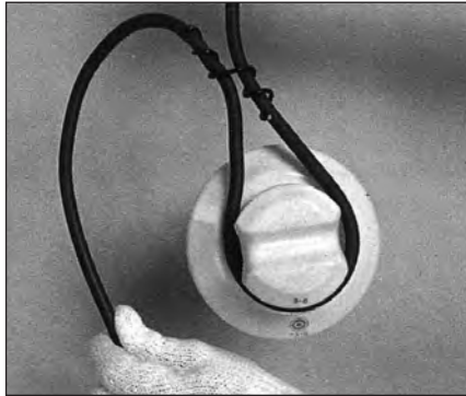
引下線上部取付方法（箇所）
